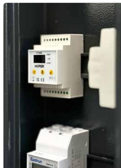
Le contrôleur Morek HUB DLM (également appelé DLB ou LMC) répartit uniformément l'alimentation entre plusieurs bornes de recharge, optimisant ainsi l'utilisation du réseau dans les limites du courant disponible et des besoins de charge. Pour les emplacements équipés de plusieurs bornes de recharge.
